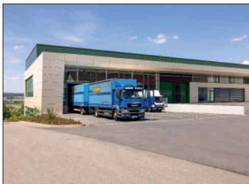
Centre logistique Nedo
