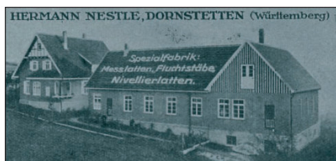
Edificios corporativos en el Riedsteige 1913
